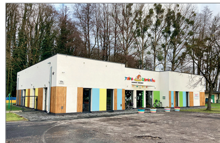
Żłobek w Dobrodzieniu, 2021
