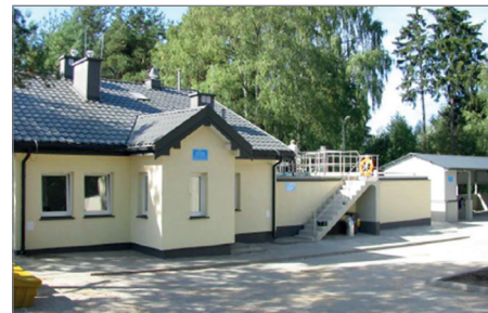
Oczyszczalnia ścieków w Pludrach, 2015
