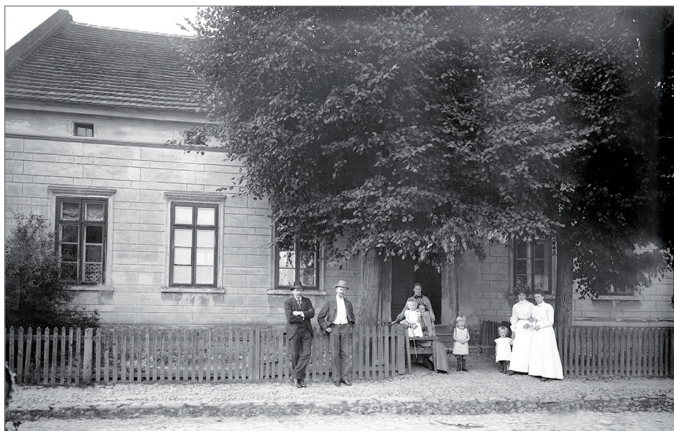
Szkoła ewangelicka w Dobrodzieniu [Guttentag], budowana w latach 1859–1860
