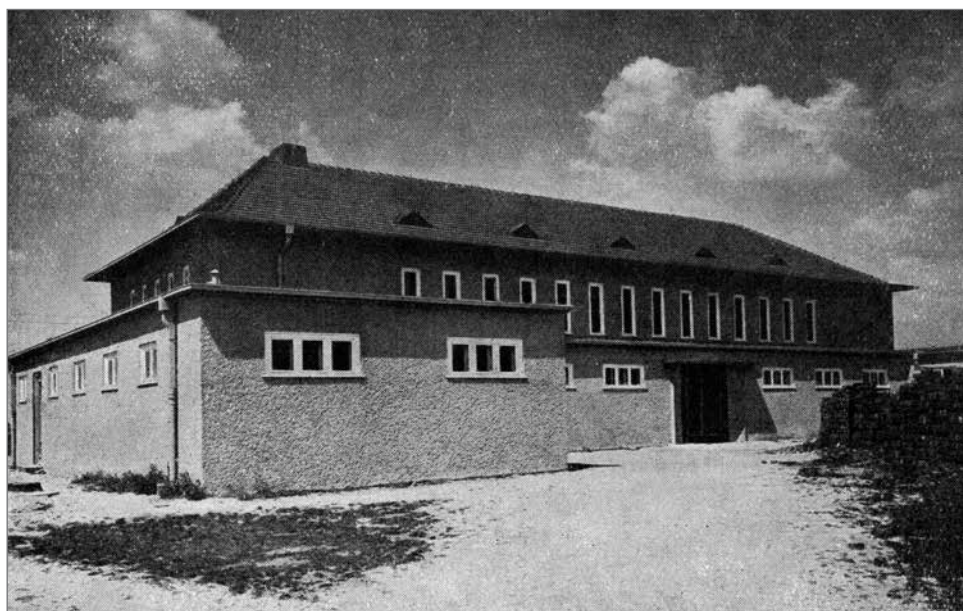
Hala Młodzieżowa w Dobrodziewiu – wygląd od strony ulicy Oleskiej, 19 VIII 1928. W pobliżu (po prawej stronie hali) uruchomiono 42-metrową wieżę wodną, również w 1928 roku
