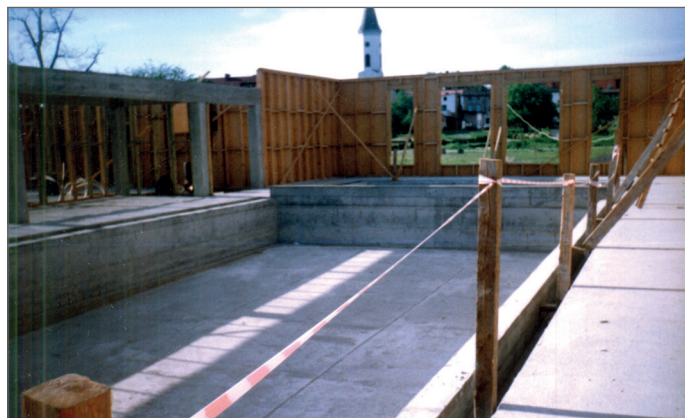
Grudzień 1999. Budowa niecki basenowej, ustawianie konstrukcji szkieletowej pływalni (fot. M. Bryś)
