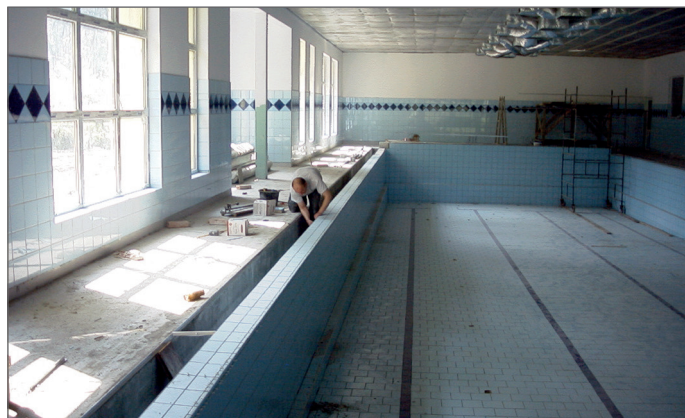
Czerwiec 2001. Czyszczenie kafelek, malowanie ścian, zakładanie paneli sufitowych (fot. P. Mrozek)
