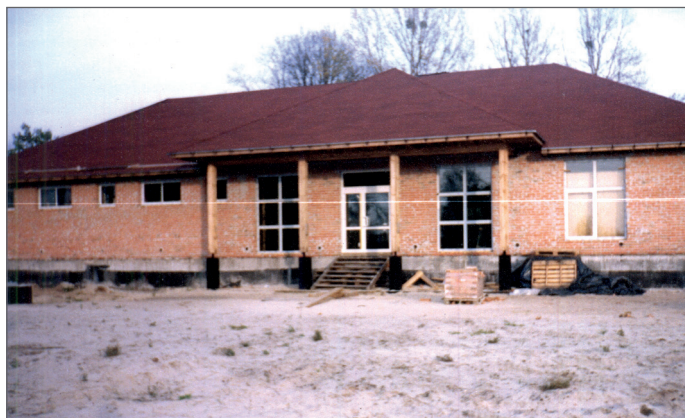
Listopad 2000. Stawianie ścian, prace murarskie i dachowe (fot. M. Bryś)
