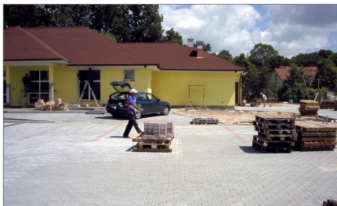
Lipiec 2001. Zakończenie brukowania, porządkowanie terenu przed pływalnią, mycie okien (fot. P. Mrozek)
