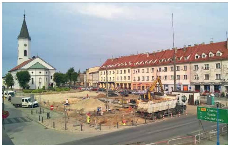
Przebudowa płyty dobrodzieńskiego rynku
