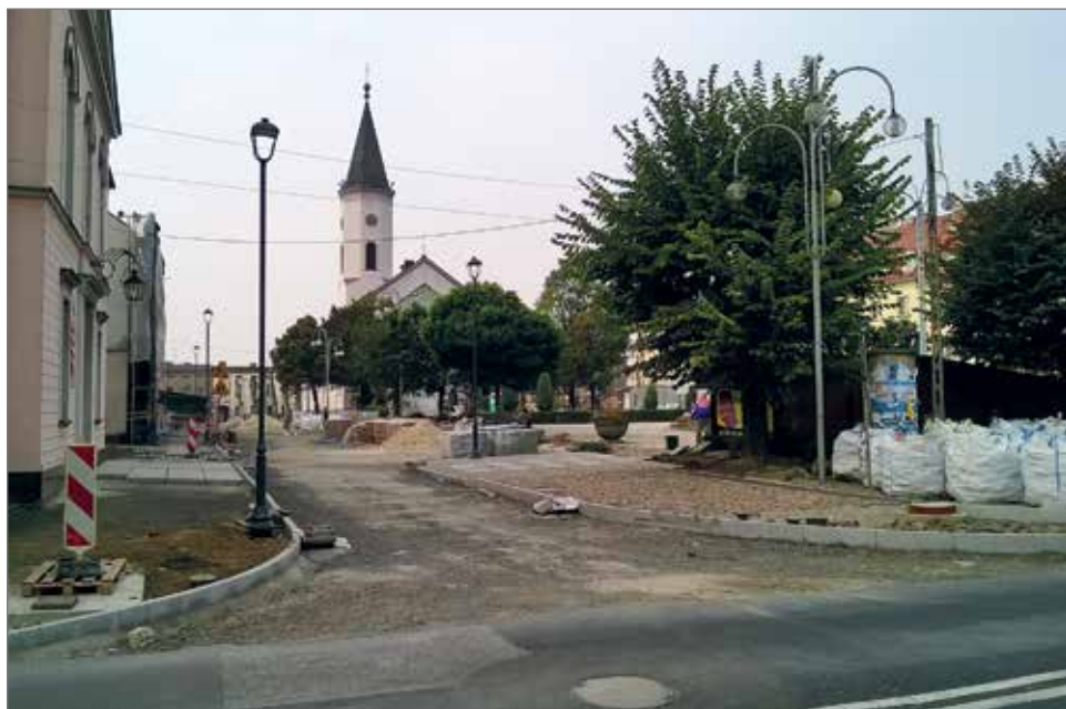
Przebudowa ulic i chodników wokół dobrodzieńskiego rynku
