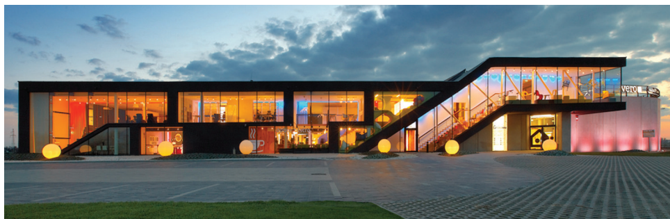
Ilustracja 8. DOBROTEKA – nowoczesny obiekt łączący funkcje salonu meblowego, centrum edukacyjno-szkoleniowego i laboratorium projektowo-badawczego w Dobrodzieniu, budowany w latach 2011–2012 przy zastosowaniu najnowszych technologii. Ze zbiorów firmowych
