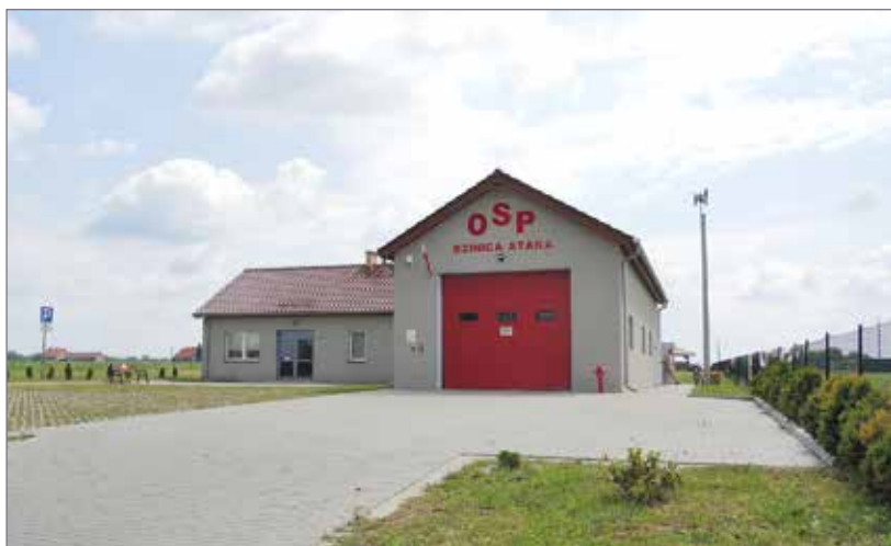
Nowo wybudowana remiza straży pożarnej w Bzinicy Starej
