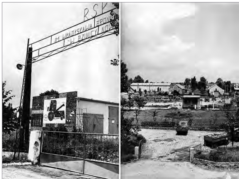
Brama wjazdowa na teren Rolniczej Spółdzielni Produkcyjnej w Bzinicy Nowej”
