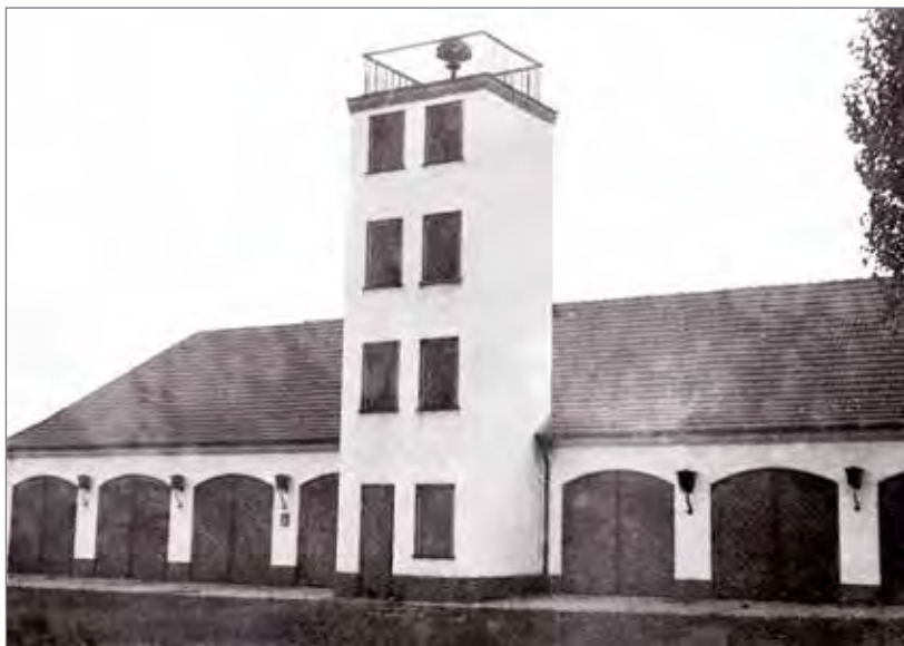
Remiza Ochotniczej Straży Pożarnej, wybudowana w 1940 roku
