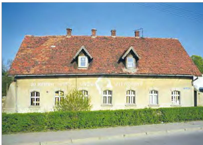
Pływalnię wzniesiono na terenie dawnego ogrodu i domu pracowników królewskiego tartaku
