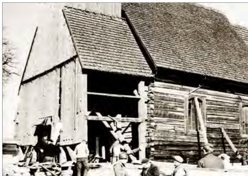
Remont kościółka św. Walentego w latach 1971–1972
