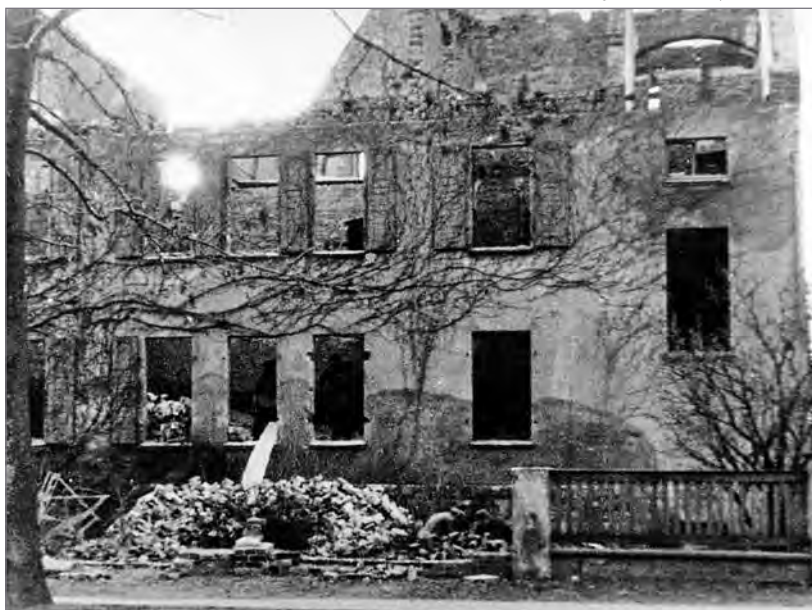
Budynek szkolny, zniszczony przez wojsko radzieckie w styczniu w 1945 roku
