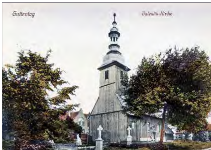
Kościół św. Walentego, o długości 18 i szerokości 10 łokci, z drewnianą zakrystią (przed 1945)
