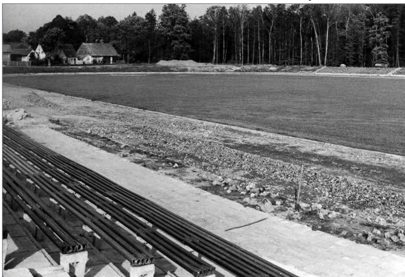
Budowa stadionu miejskiego w 1977 roku
