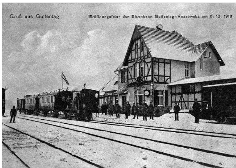
Dworzec kolejowy w Dobrodzieniu [Guttentag], oddany do użytku w 1913 roku
