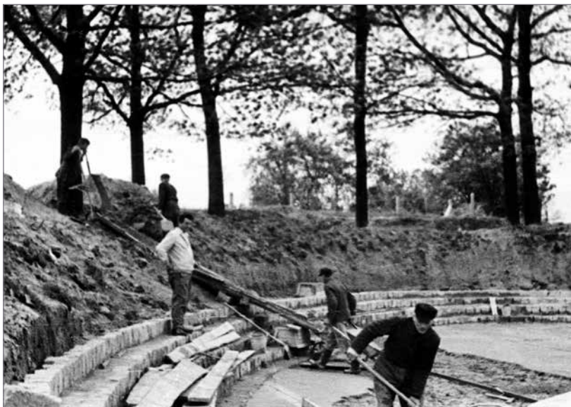
Budowa basenu w Leszczu w 1965 roku
