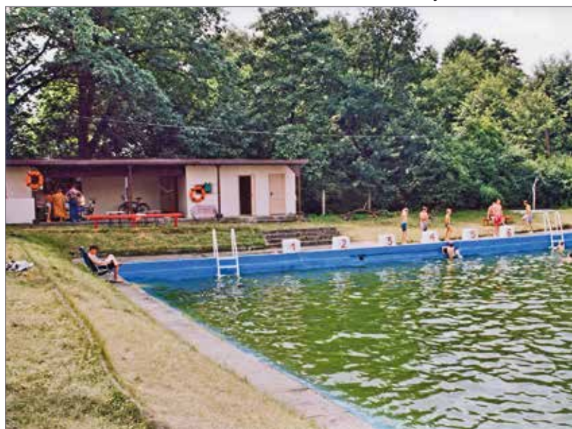
Basen otwarty po remoncie w 1998 roku
