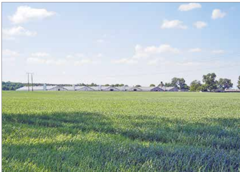
Widok na zabudowania fermi drobiu
