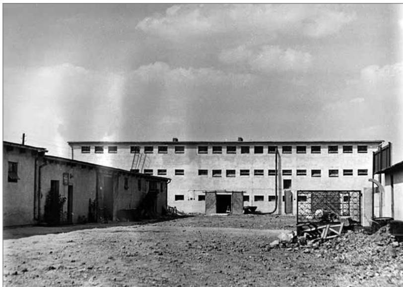
Budowa kompleksu magazynów „Nowy świat” w latach 70. XX wieku
