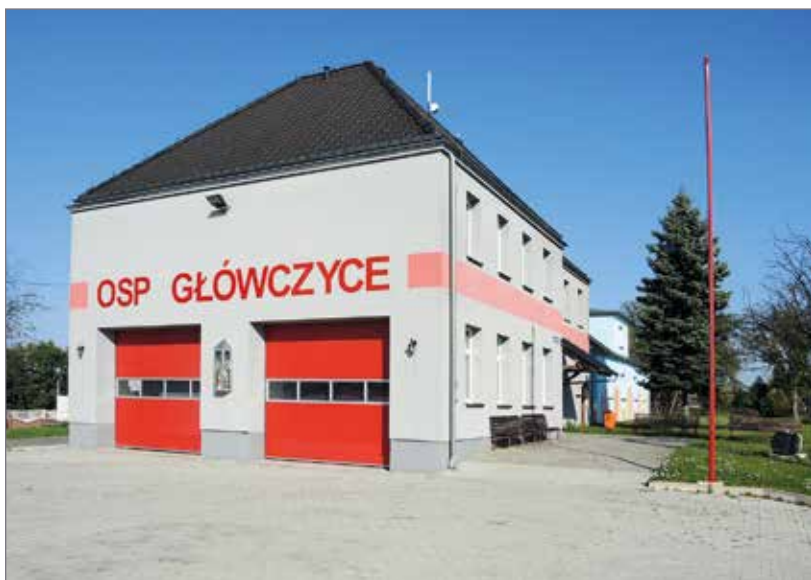
Remiza strażacka i wiejskie centrum kultury w budynku dawnej szkoły
