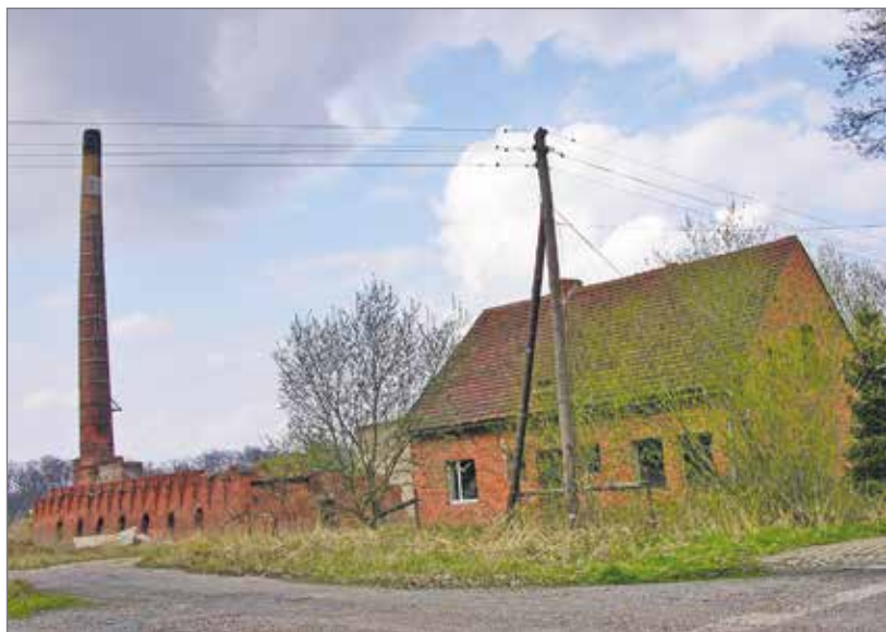
Nieczynna cegielnia w Przywarach i opuszczony dom przedwojennego właściciela
