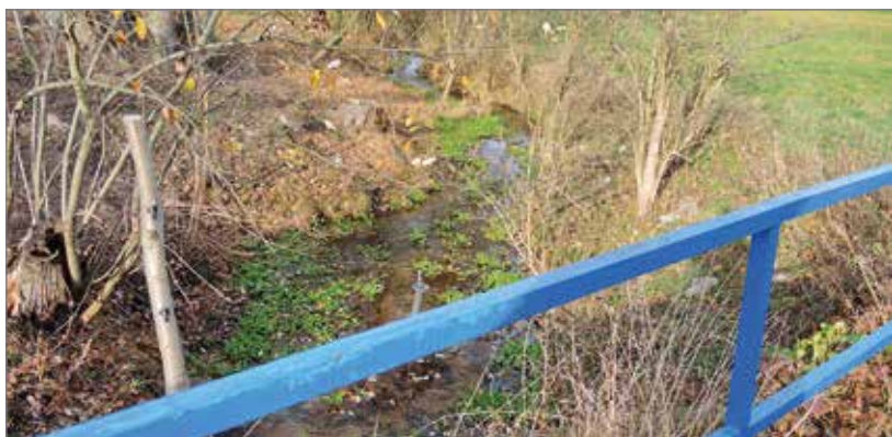
Ulica Warłowska w sołectwie Makowczyce • Betonowy mostek na cieku wodnym
