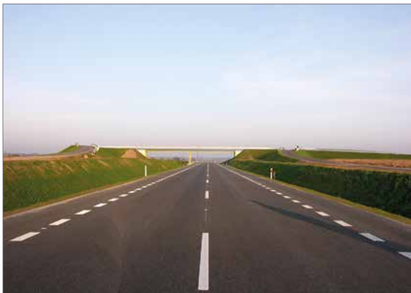
Druga część pierwszej obwodnicy Dobrodzienia, stan 18.10.2006
