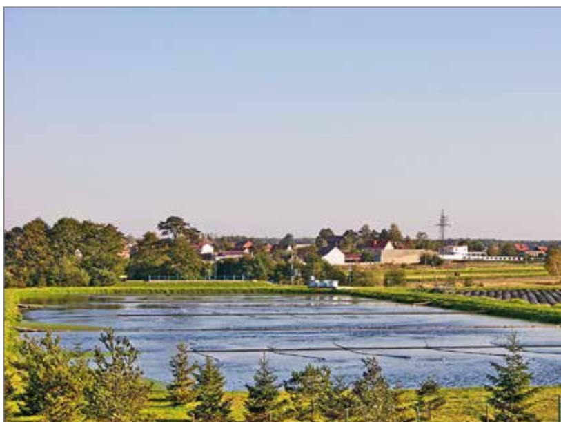
Mechaniczno-biologiczna oczyszczalnia ścieków „LEMNA”, wybudowana w 1998 roku
