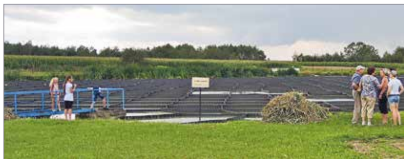
Zwiedzanie oczyszczalni ścieków w Dobrodzieniu/Ligocie
