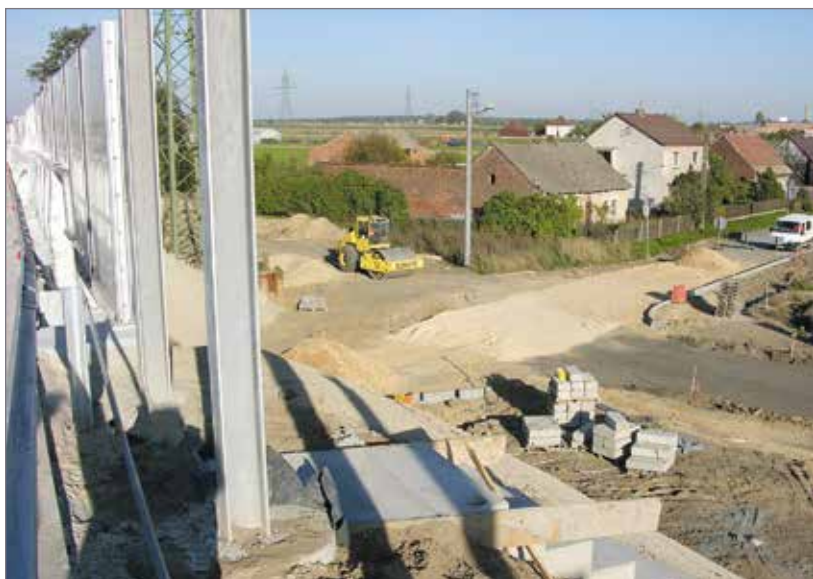
Budowa wiaduktu nad ulicą Wojska Polskiego w Ligocie Dobrodzieńskiej , stan 18.10.2006
