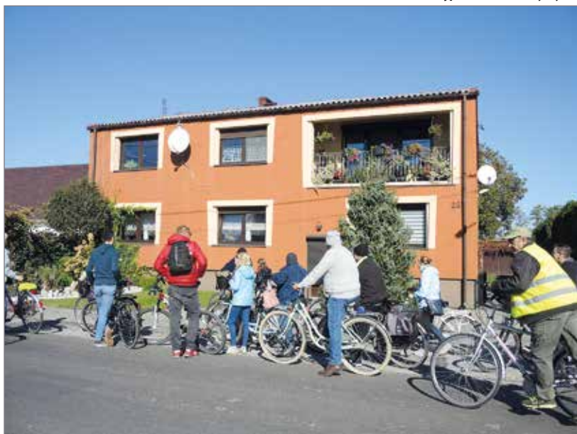
Dawna karczma jako budynek mieszkalny
