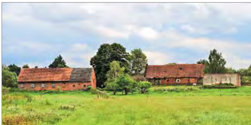
Pozostałości zabudowań folwarcznych z XIX/XX wieku w Makowczycach 1. Widok od strony ulicy Głównej • 2. Widok od strony pól • 3. Widok od strony ulicy Wiejskiej Fot. Paweł Mrozek
