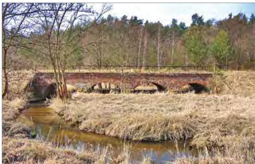
Widok na wiadukt kolejowy nad rzeką Myśliną od strony budynku szkolnego
