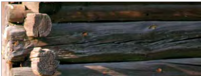
Fragment ściany z płazów na zakładkę prostą z ostatkami w konstrukcji zrębowej
