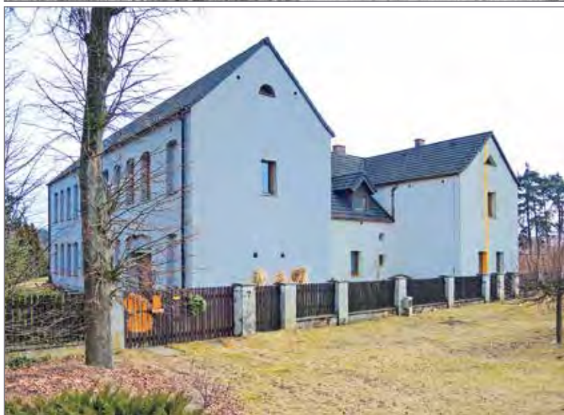
Szkoła w Myślinie – pocz. XX w. • Prywatny budynek mieszkalny w 2018
