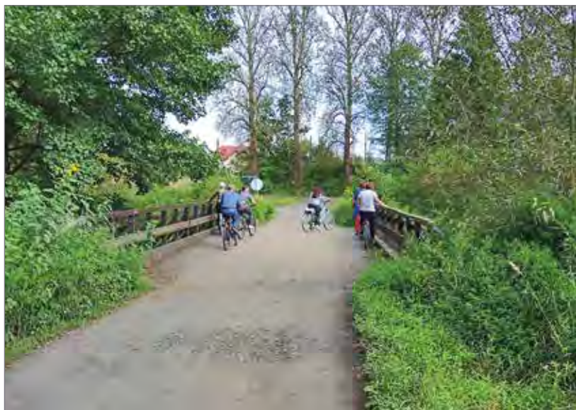
Drewniany most w Turzy na rzece Myślinie, wybudowany przez wojsko w latach 80. XX w.
