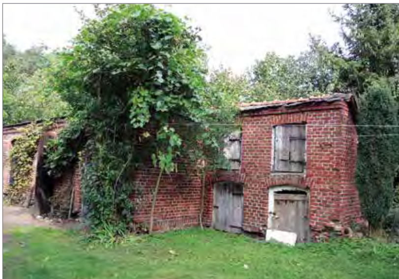
Pozostałości budynków dawnej kuźnicy w Turzy – murowane szopy i piekarnik
