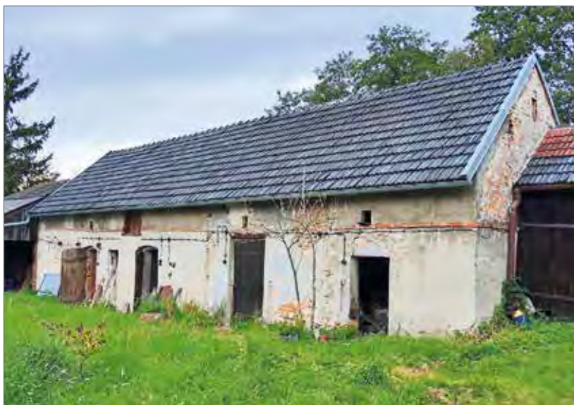
Jeden z budynków z kompleksu młyn – kuźnica – dom mieszkalny
