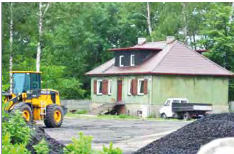
Przyzakładowy budynek „stalowy” w Pludrach w roku 2008 – teraz własność prywatna
