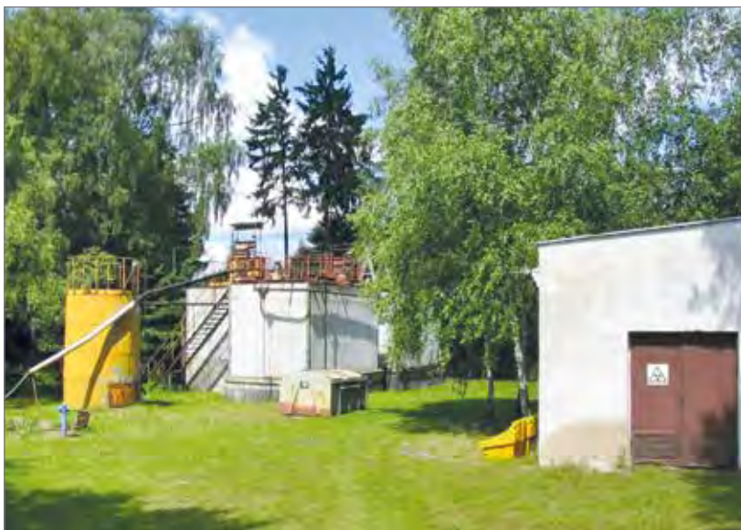
Oczyszczalnia ścieków w Pludrach przed rozpoczęciem przebudowy w 2013 roku
