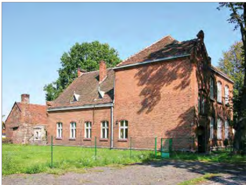
Budynek szkolny w Pludrach z 1896 roku – strona zachodnia
