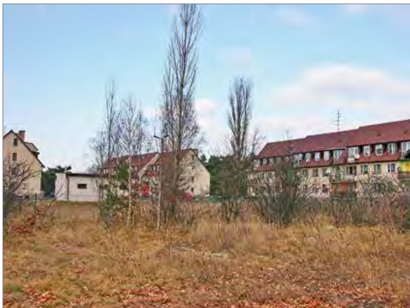
Osiedle Robotnicze w Pludrach, wybudowane w 1987 roku przez Nasycalnię Podkładów
