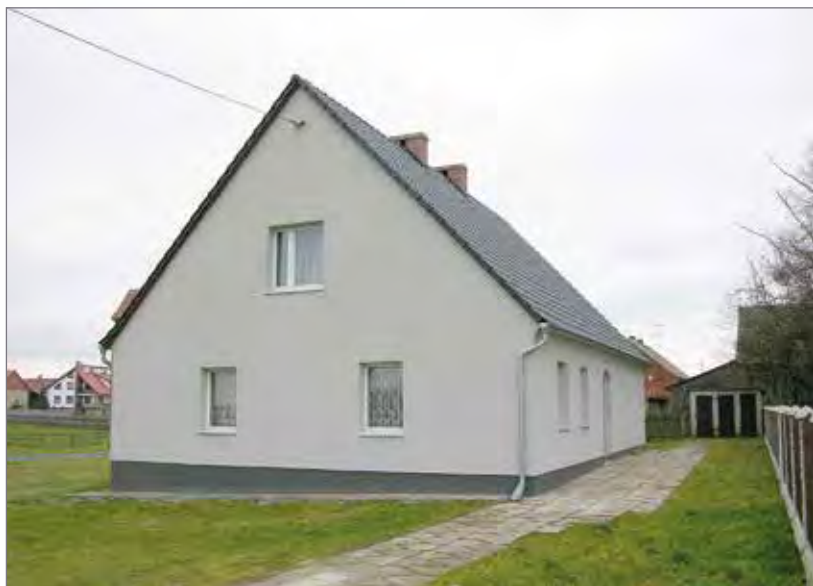
Budynek szkolny z roku 1844 – wiejski dom spotkań od 1992
