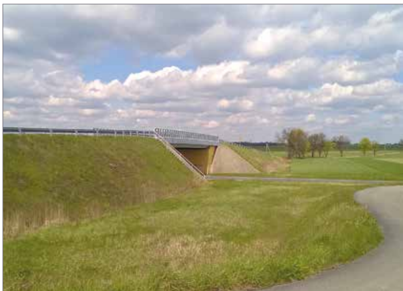
Wiadukt na ulicy Rzędowickiej, budowany w latach 2007–2008
