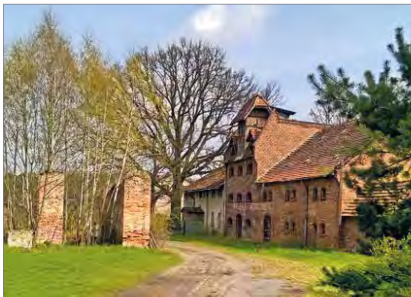
Zrujnowane zabudowania dawnego folwarku; stan współczesny
