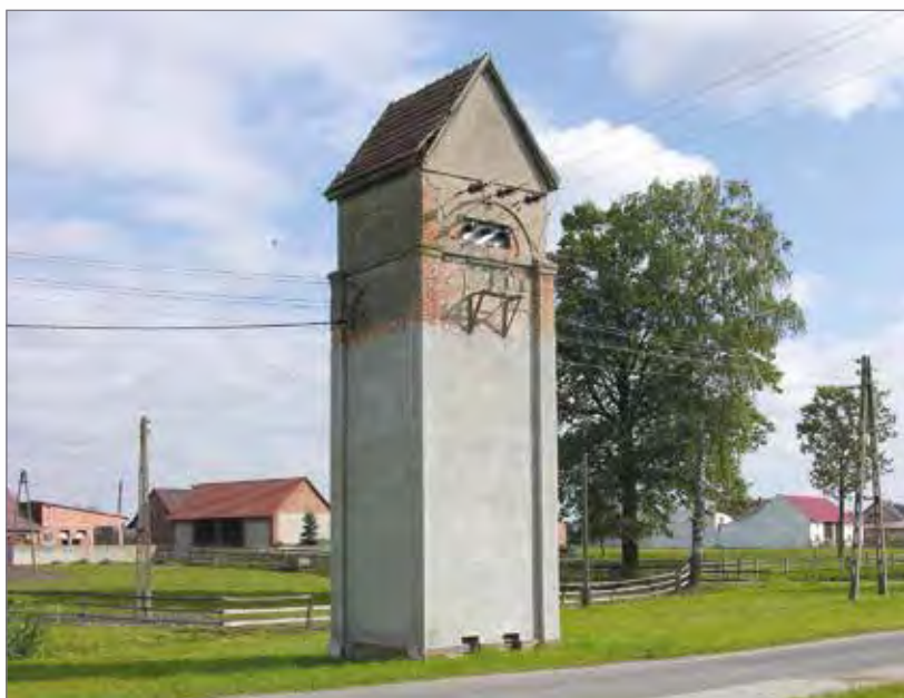
Stacja transformatorowa w Rzędowicach z 1927 roku
