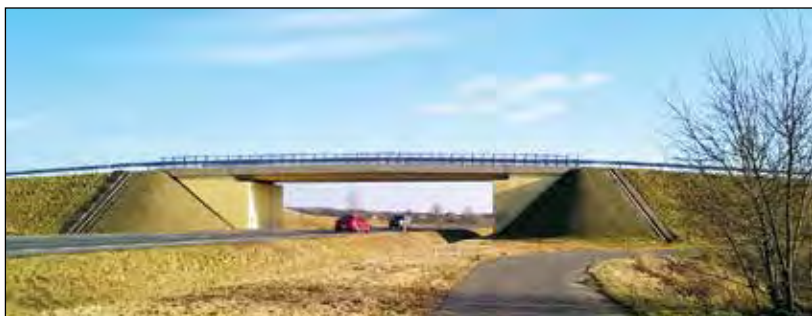
Wiadukt „w polu” między Dobrodzieniem a Hadasikami
