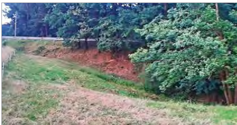
Wiadukt na rzece Myślinie w Rzędowicach-Pustkowie
