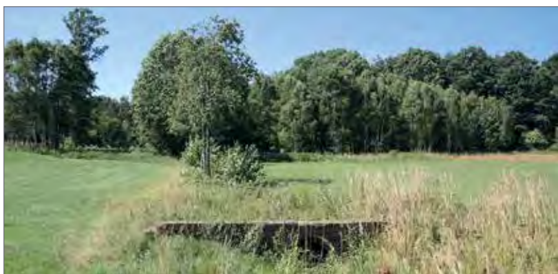
Widok na Glinioki od ulicy Leśnej i murowany mostek na Libawce w Gliniokach
