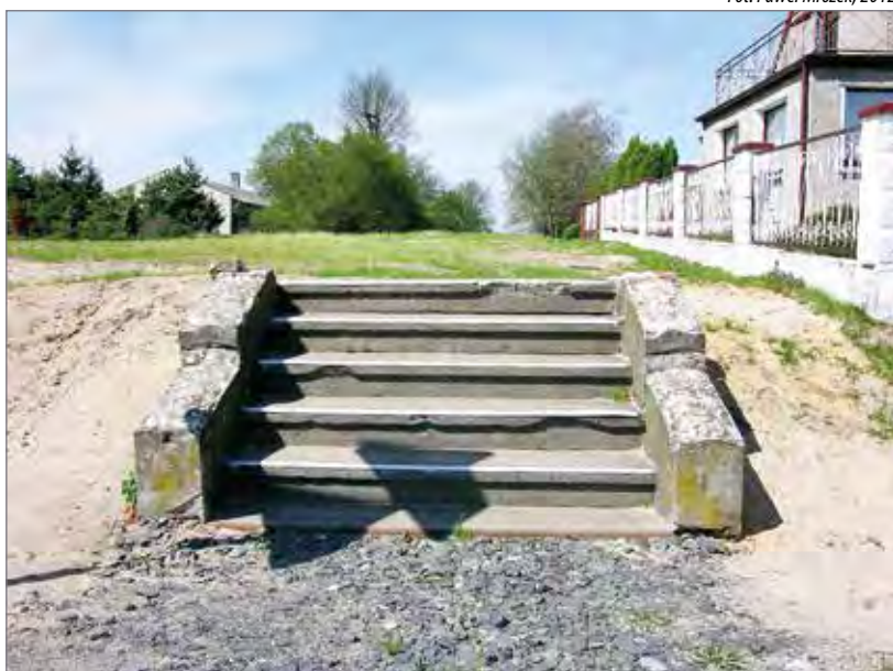
Schody – jedyny ocalały fragment przedwojennego budynku szkolnego
