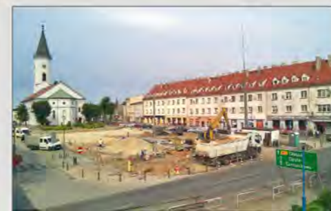
Przebudowa płyty dobrodzieńskiego rynku / Umbau der Mitte des Guttentager Rings Fot. / Abb. Paweł Mrozek, 12.08.2019
