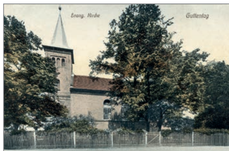
1848–1851 • Budowa kościoła ewangelickiego
