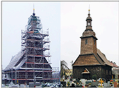
Remont kościoła św. Walentego w latach 2009-2010 Fot. Paweł Mrozek, 2011
