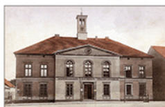
Pałac w Dobrodzieniu, budowany w stylu neoklasycystycznym w latach 1848-1849 Restruje wg projektu ze zbiorów Pawła Mroza
