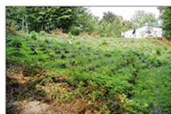
Niezrealizowana inwestycja – amfiteatr w ruinie Fot. Paweł Mrozek, 2003
