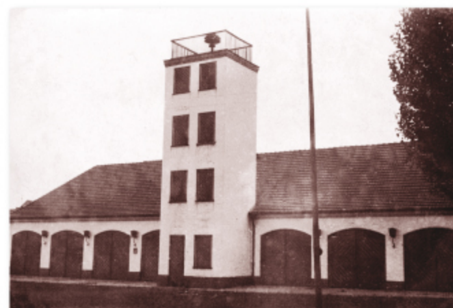
Nowo wybudowana remiza strażacka w Dobrodzieniu
