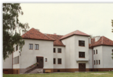
• 1992 • Odremontowany budynek szkolny Zd. zbior. Urząd Miasta
