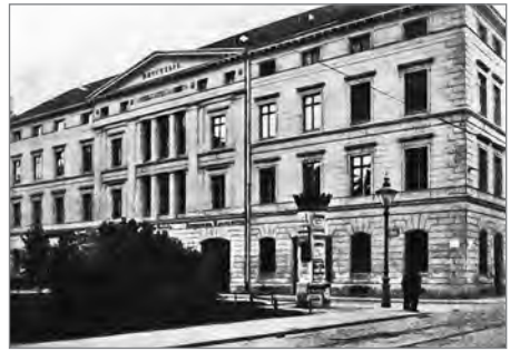
Stary budynek gimnazjum im. Wiktorii we Wrocławiu Fot. ze zbiorów Edith-Stein-Archiv zu Köln
