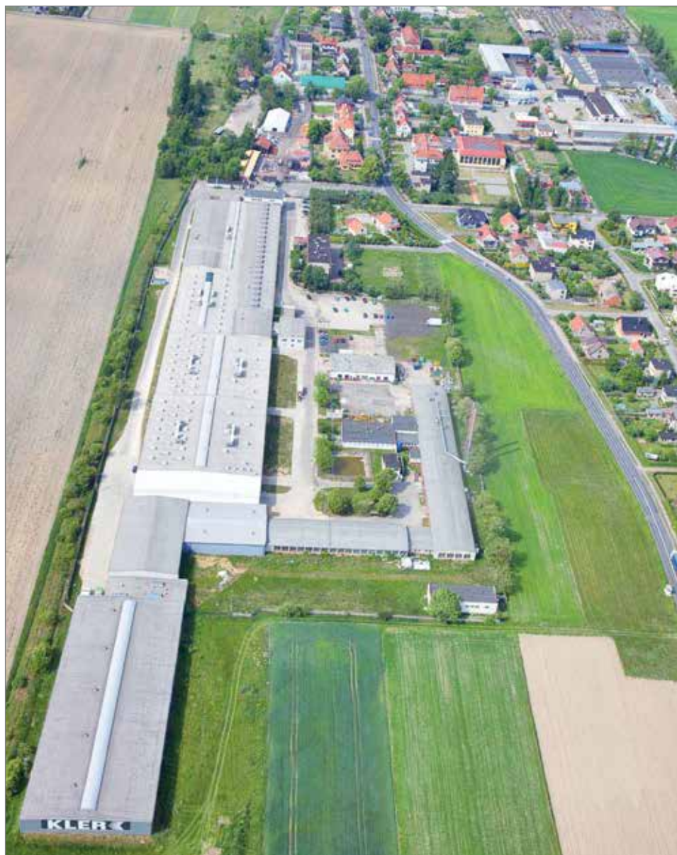
KLER SA – największy zakład meblarski w Dobrodzień Die größte Möbelfabrik in Guttentag
